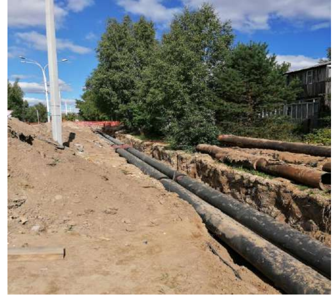
Реконструкция магистральной теплотрассы Ø325 мм ул. Космонавтов от ТКН-7 (около ДК "Нефтяник") до ТКН-15 (около ж.д.Д-43)
